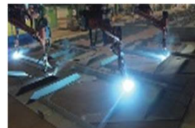
自動溶接ロボット
